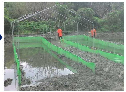
圖 30 將鋸管棚架插入土中
