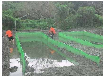
圖 29 架設鋸管棚架
