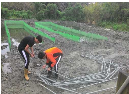
圖 28 拆鋸管棚架底座塑膠套
