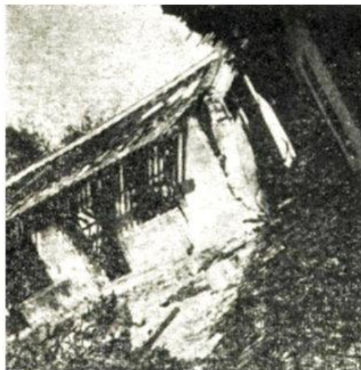
新港忠孝里民房損壞
