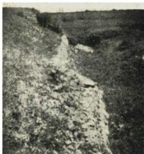
加禮彎路基東部地塊向北移動40公分
