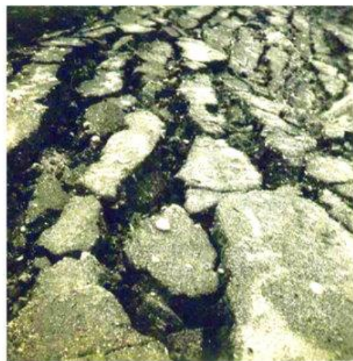
南濱海堤堤內沙礫層之陷裂情形，裂痕呈N-S走向，裂開20-30公分，下陷1公尺 向NE攝
