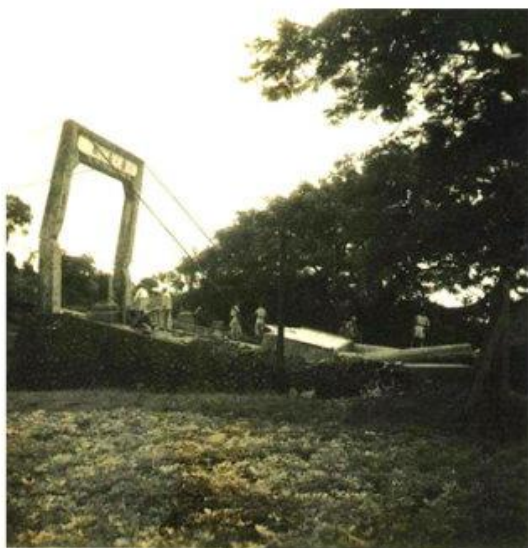
忠烈祠前尚志橋吊橋折斷及牌坊之傾折
