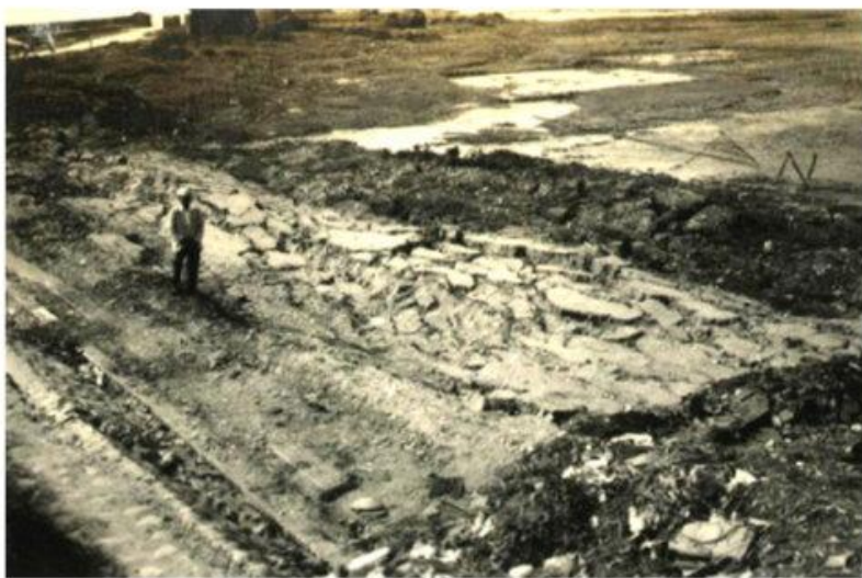
南濱海堤堤內沙礫層之陷裂情形，裂痕呈N-S走向，裂開20-30公分，下陷1公尺 向NE攝
