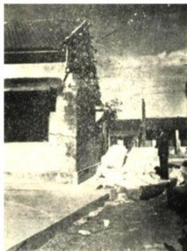
馬蘭房屋損壞情形
