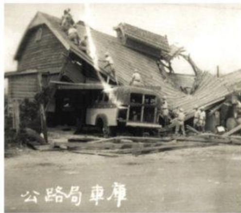
花蓮公路局車庫屋塌壓毀公車
