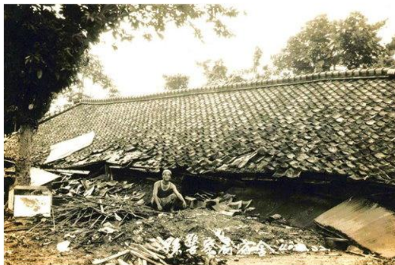
公園路一帶警察宿舍倒塌
