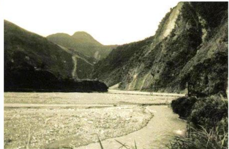
花蓮銅門山崩遠景，銅門吊橋之東西向支索已斷，10月22日11:30地震後向西攝。
