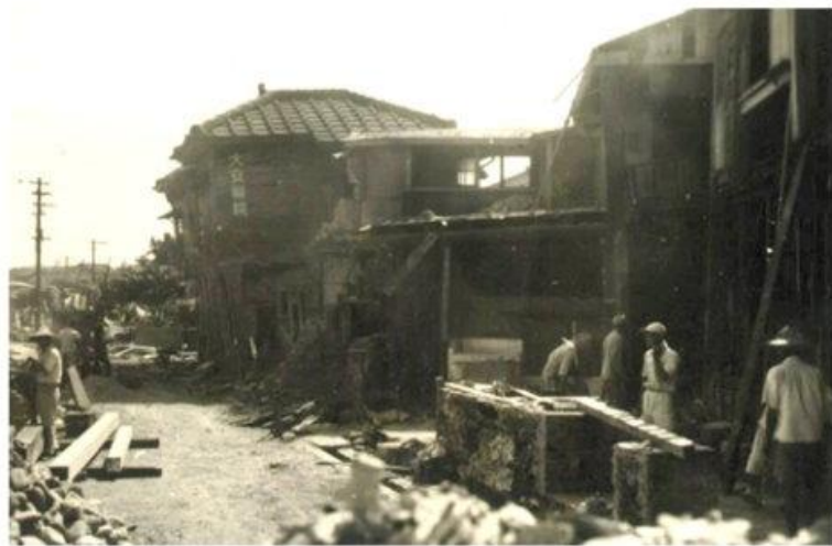
花蓮市大安醫院附近水泥磚階梯裂開4公分，向S20°E攝。
