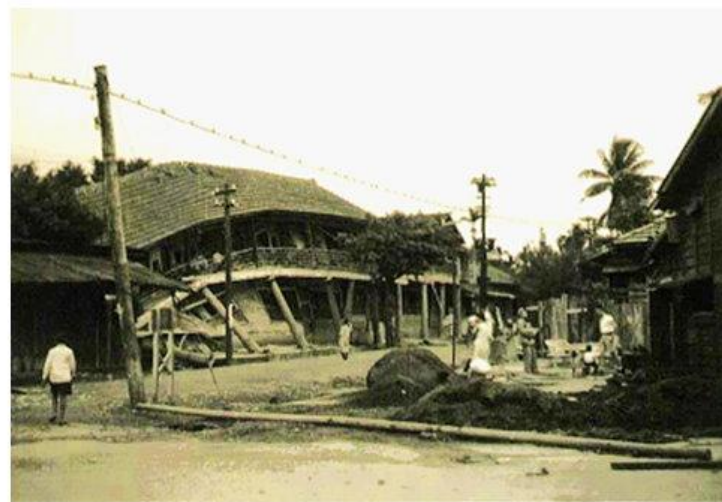
五權街第一旅社(鋼筋混凝土支柱)向北傾倒，向N60°E攝，旁邊東淨寺亦倒塌。
