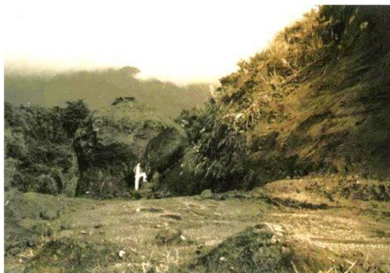
長濱公路為崩落之巨大石塊所阻塞，10月 22日05:30地震後向SSW攝。
