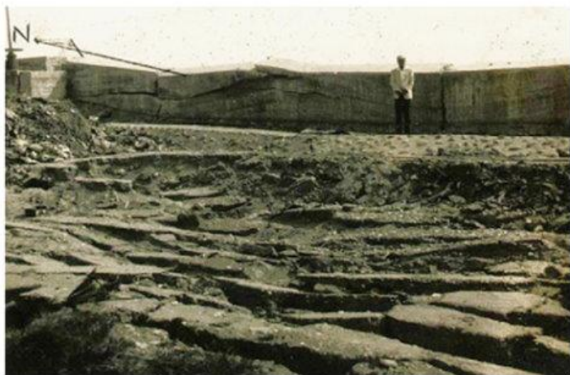
南濱混凝土海堤上部之小型逆掩斷裂，南北水平移動約40公分，向東攝。
