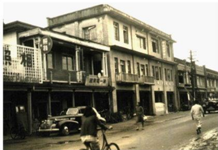
花蓮市中山路三層鋼筋水泥建物華南商業銀行未受損害
