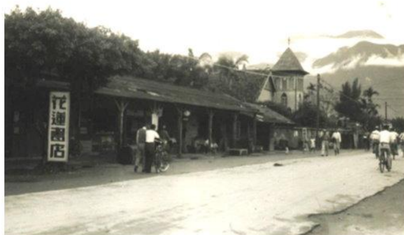
花蓮市中山路之簡單木屋及教堂(花蓮港基督教長老教會)內部破壞嚴重，向西攝。
