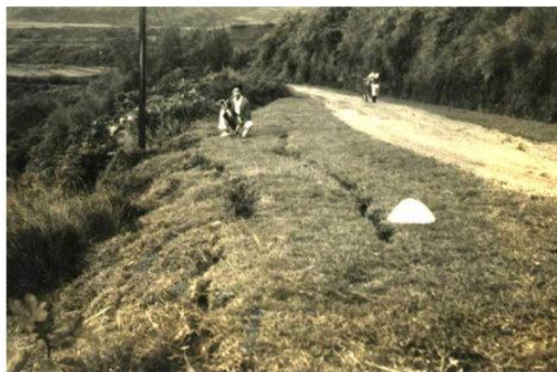
長濱公路陷裂情形，10月22日05:30地震後 向S攝
