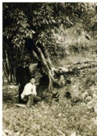
大富附近斷層線所經處，樹木傾倒，東側升高1.3公尺，11月25日地震後向NW攝。
