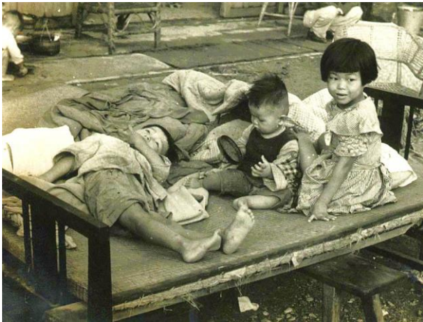
房屋倒塌露宿街頭情景
