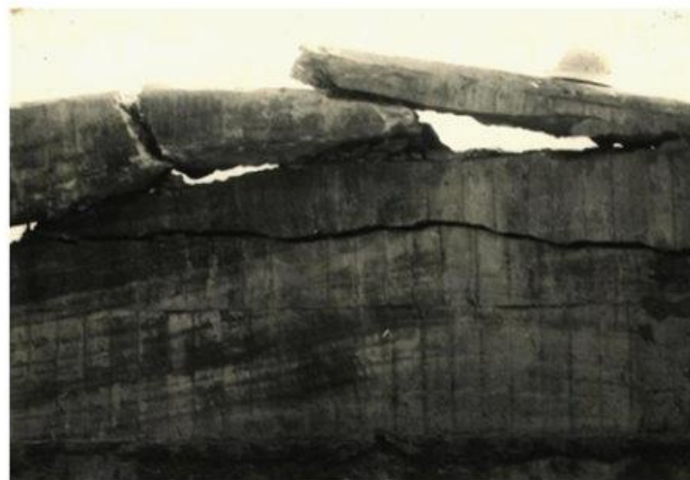
南濱混凝土海堤上部之小型逆掩斷裂，南北水平移動約40公分，向東攝。
