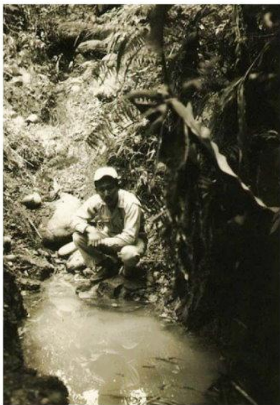
富源村之地裂，寬1公尺，深5.5公尺，11月25日地震後向N攝
