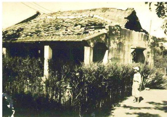
馬蘭民房之瓦亂及部分崩落，12月5日地震後攝
