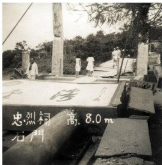
花蓮忠烈祠橋頭高8公尺之石門倒壞
