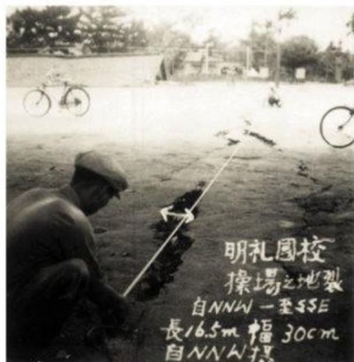
明禮國校操場呈NNW—SSE地裂，長16.5 m寬30 cm，自NNW攝(湯捷喜提供)
