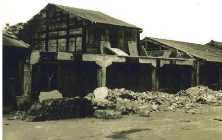
瑞美鋼筋混凝土樓房被震損折落，11月25日地震後攝。
