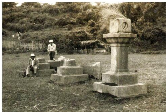
成功鎮神社石燈籠燈柱折斷並向北傾落， 向N80°W攝
