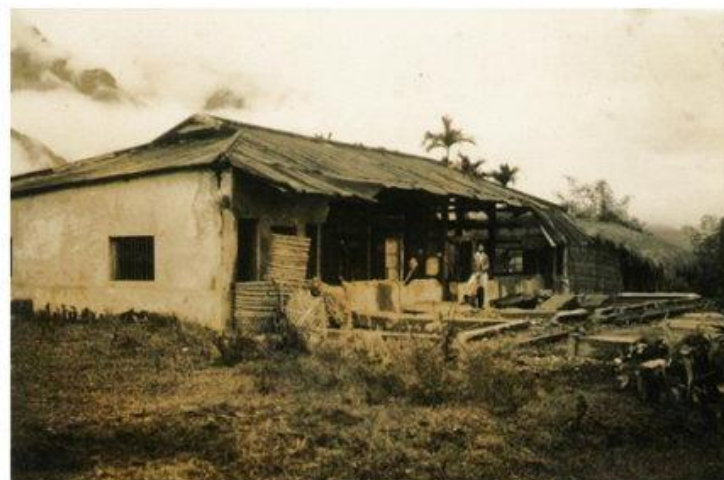
長濱忠勇村水泥鋼筋房壁向 S70^{\circ}E 倒落， 10月22日05:30地震後向 N10^{\circ}W 攝
