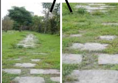
照片三、現有步道鋪砂土回填過度裸露空隙
